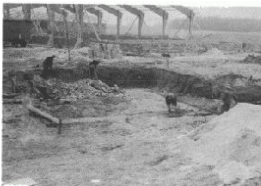
Bau der Reithalle
