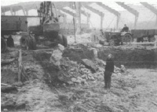
Die Reithalle entsteht: 1961
